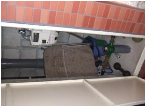
202号室パイプスペース
