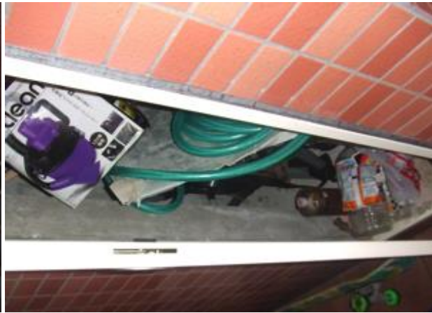
102号室パイプスペース
