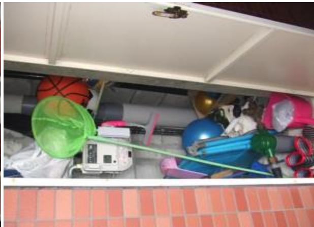
201号室パイプスペース
