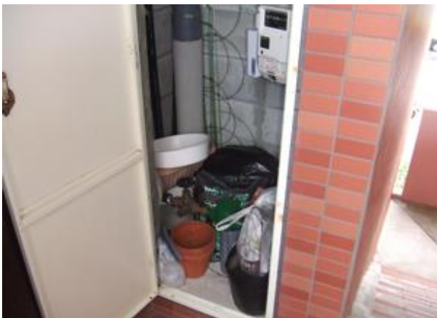
302号室パイプスペース
