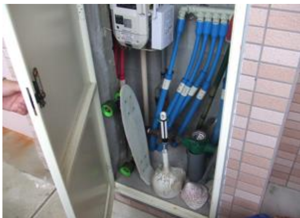
301号室パイプスペース
