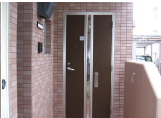
101号室 異臭あり
