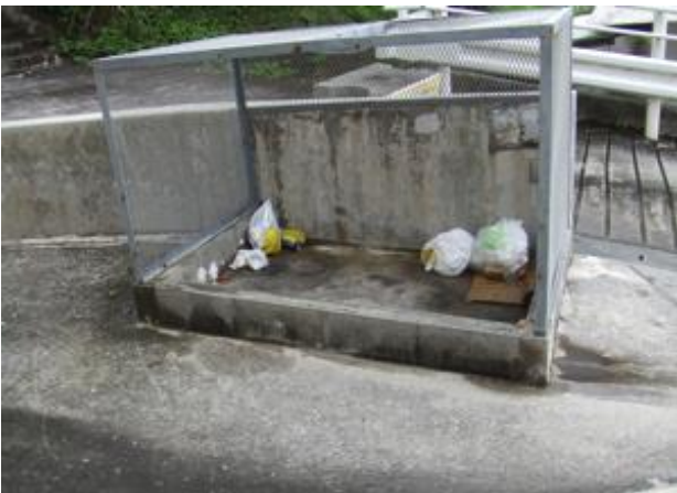
ゴミ置場ゴミあり
