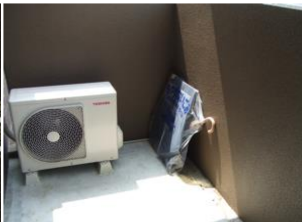
廊下にゴミあり
