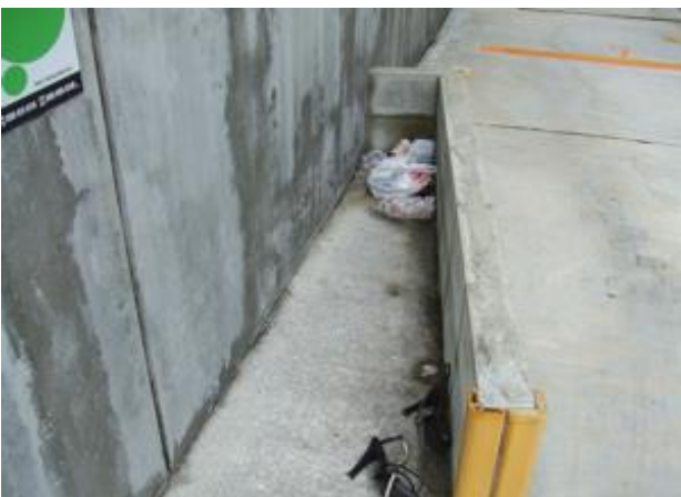
ゴミ置場ゴミあり
