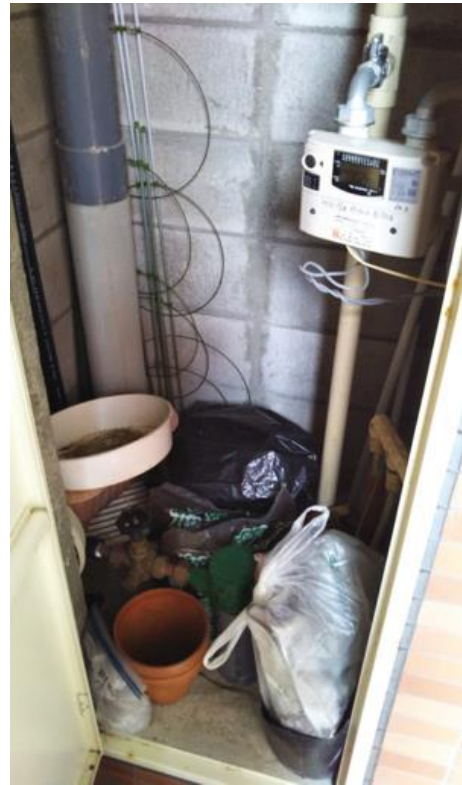
302号室パイプスペース
