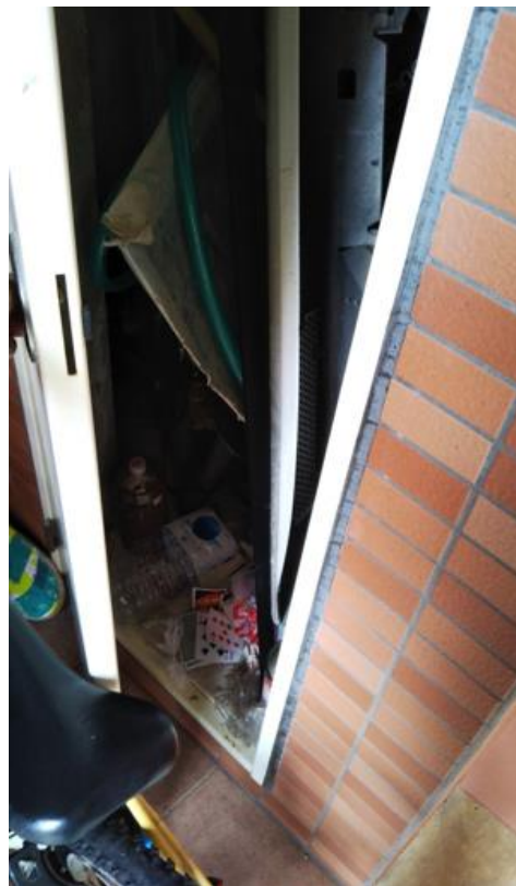
102号室パイプスペース
