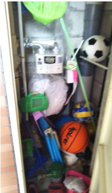
201号室パイプスペース
