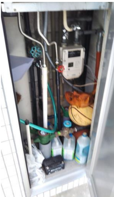
A-3号室パイプスペース
