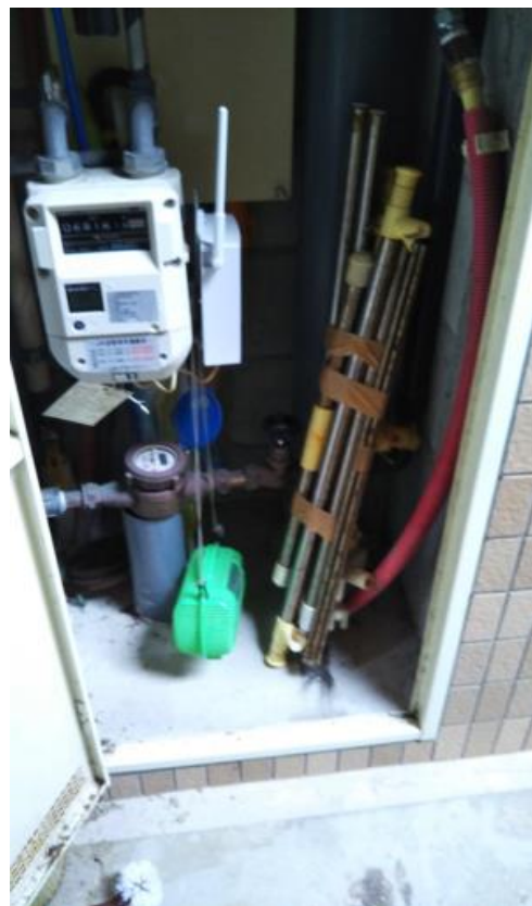
101号室パイプスペース
