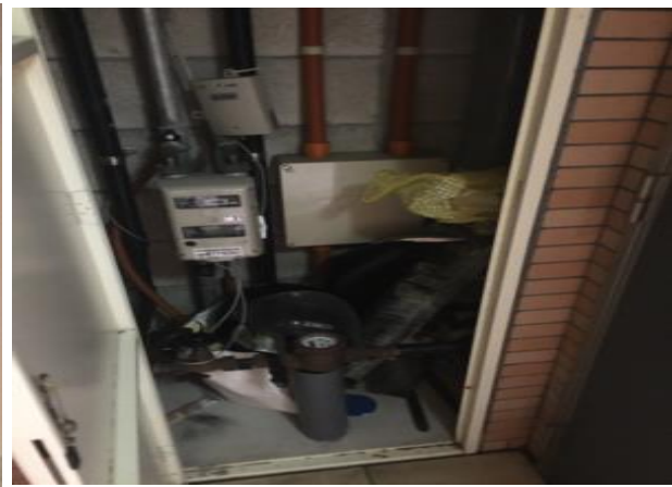
201号室パイプスペース
