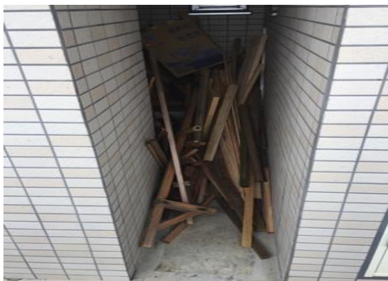
203号室共用スペース
