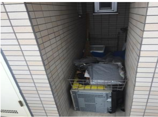
205号室共用スペース
