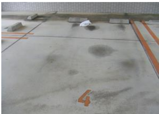
駐車場NO4 タオルがよく落ちています
