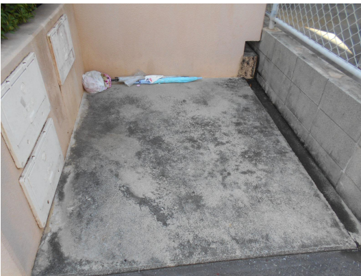
ゴミ置場・未回収ゴミあり。
