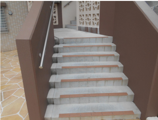
エントランス階段
