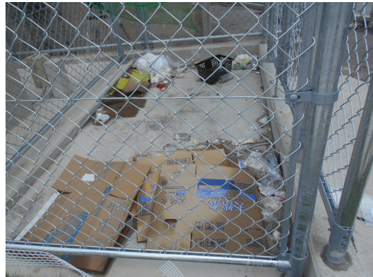
ゴミ置場・施工中の為、作業できませんでした。
