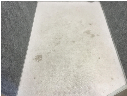
EV・ホール
