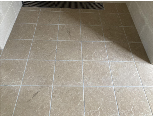
EV・ホール
