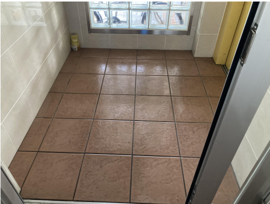
EV・ホール
