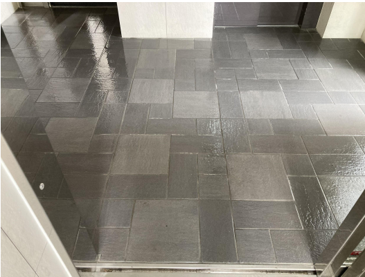
EV・ホール
