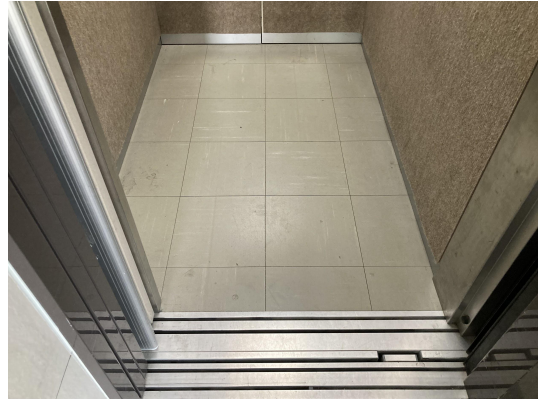
EV・ホール
