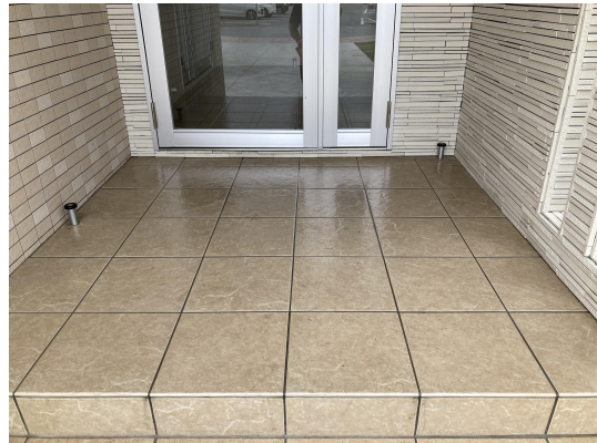
エントランススタイル
