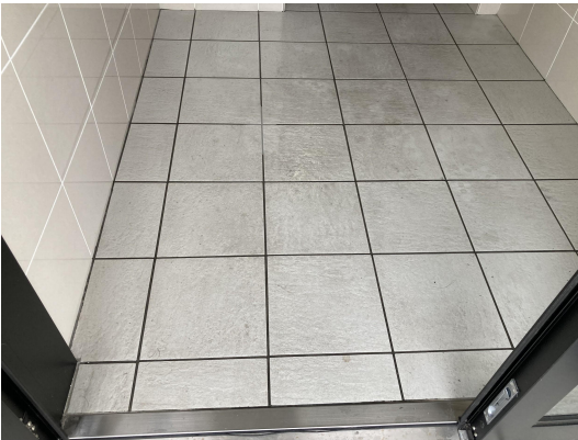
EV・ホール
