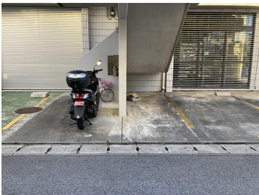
ゴミ置場・未回収ゴミあり。
