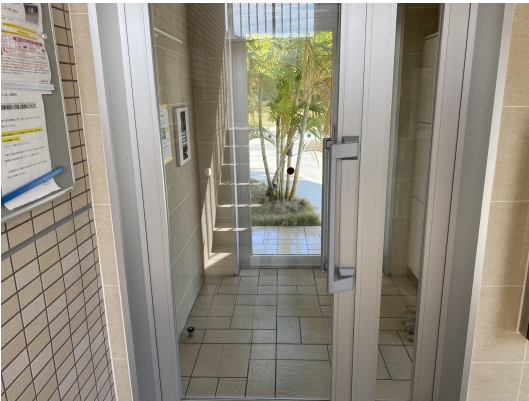
エントランスガラス
