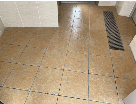
EV・ホール
