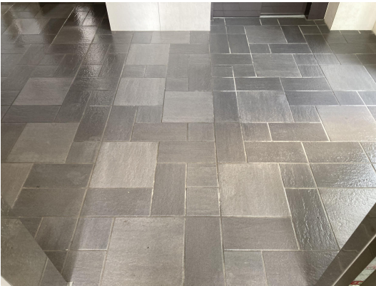
EV・ホール
