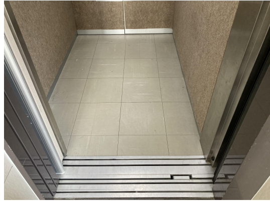
EV・ホール
