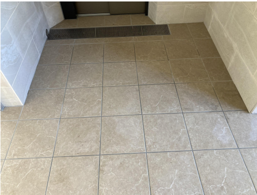
EV・ホール
