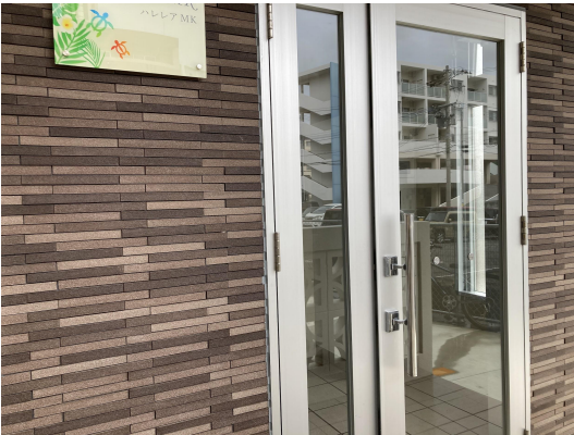
エントランスガラス
