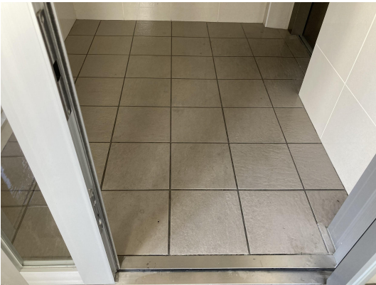
EV・ホール
