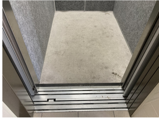
EV・ホール
