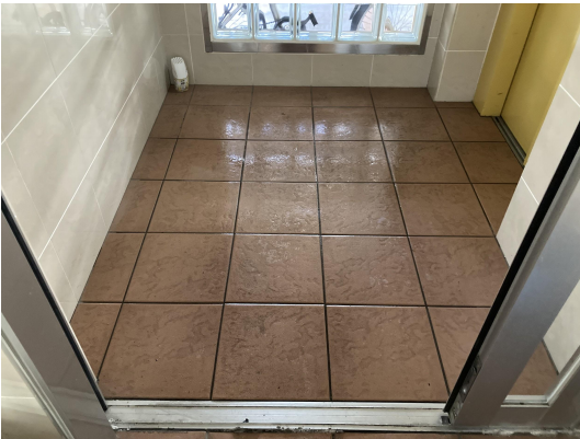
EV・ホール
