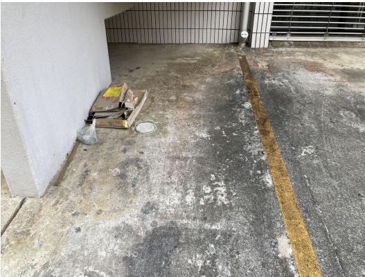
ゴミ置場・未回収ゴミあり。
