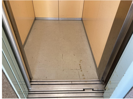
EV・ホール
