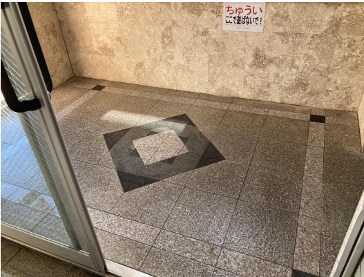
EV・ホール
