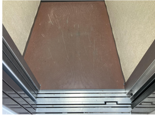
EV・ホール
