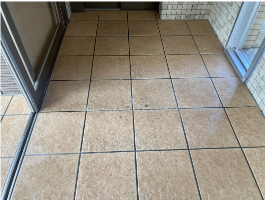
EV・ホール
