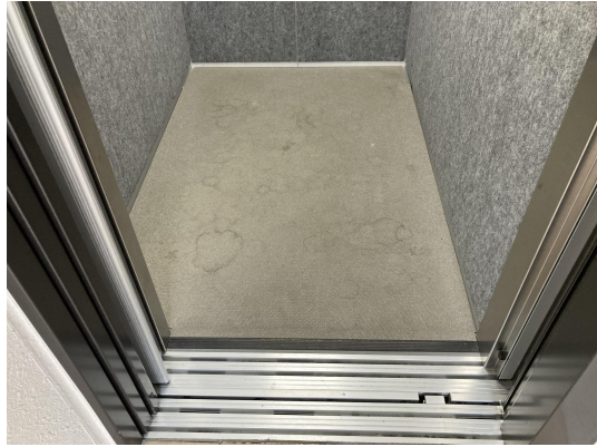
EV・ホール
