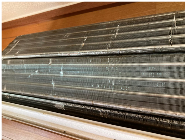
7.エアコンクリーニング
