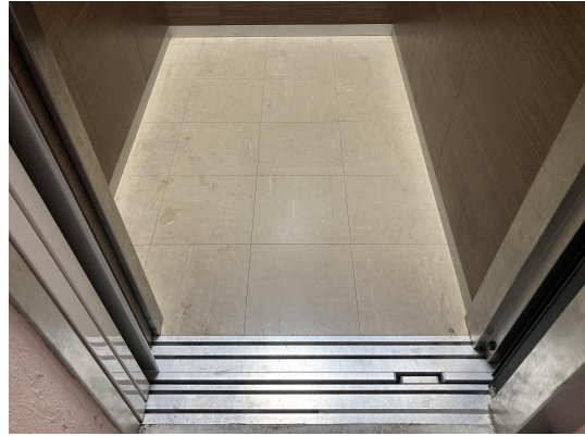
EV・ホール
