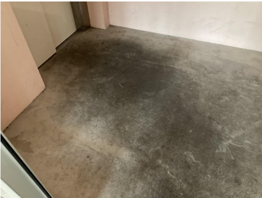
EV・ホール
