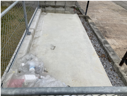
ゴミ置場・未回収ゴミあり。
