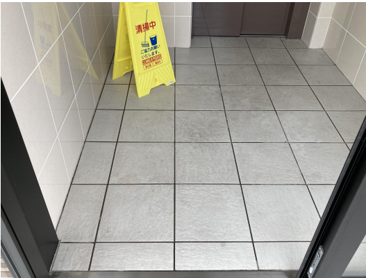
EV・ホール
