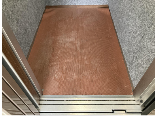
EV・ホール
