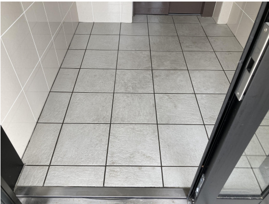
EV・ホール
