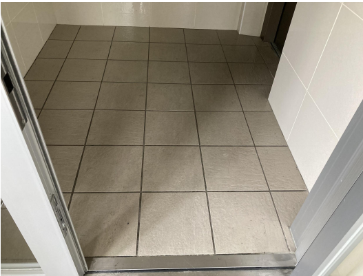
EV・ホール
