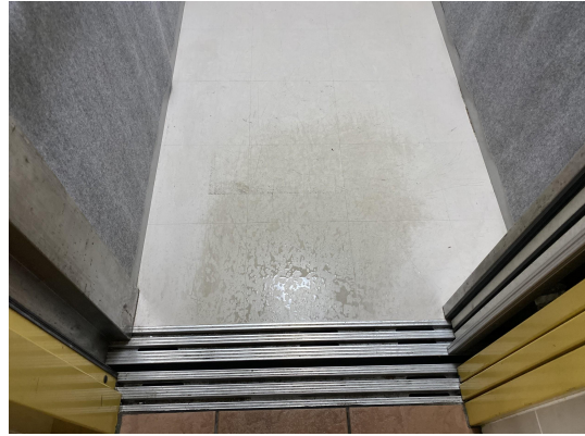
EV・ホール
