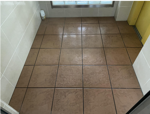
EV・ホール
