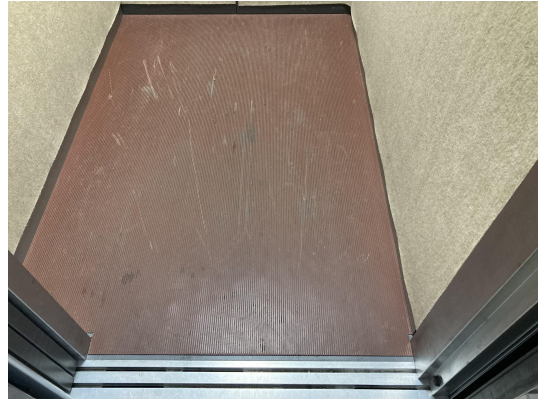
EV・ホール
