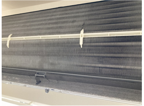
16.エアコンクリーニング
