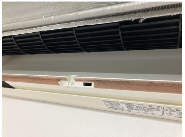
13.エアコンクリーニング
