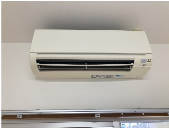
13.エアコンクリーニング
