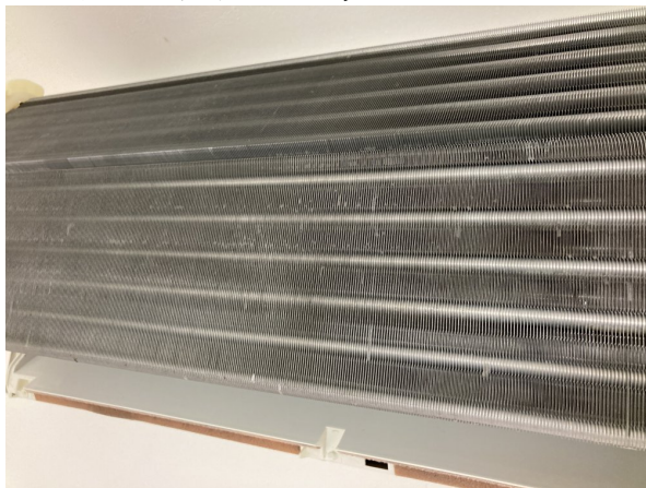
13.エアコンクリーニング
