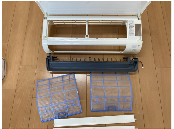
13.エアコンクリーニング
