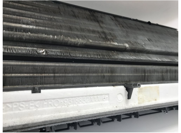
16.エアコンクリーニング
