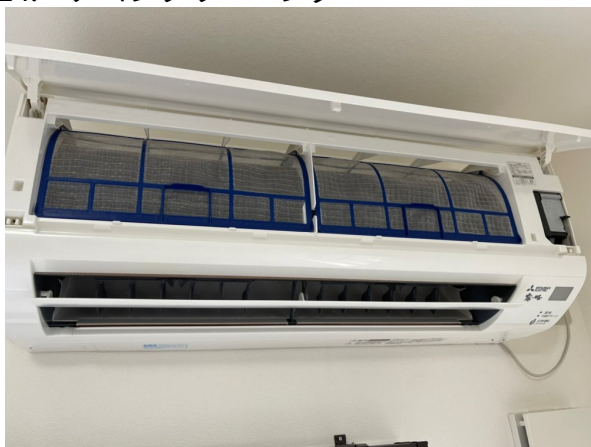
14.エアコンクリーニング
