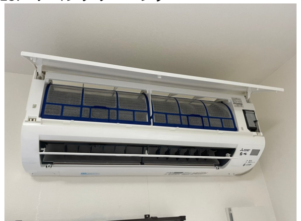
13.エアコンクリーニング
