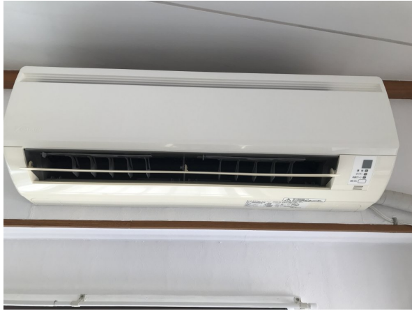
1.エアコンクリーニング
