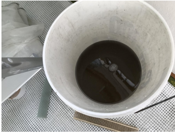
1.エアコンクリーニング
