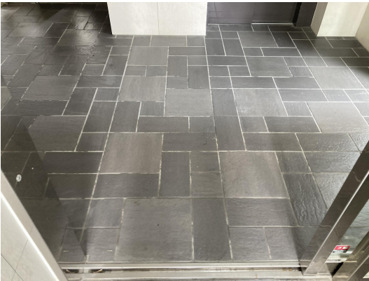
EV・ホール
