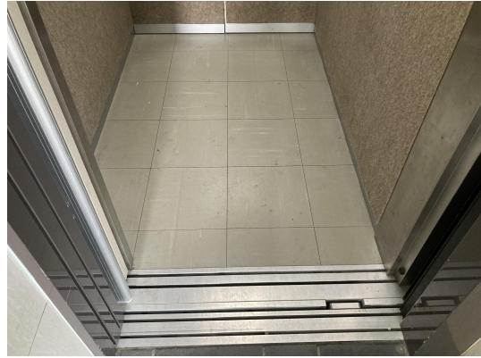
EV・ホール
