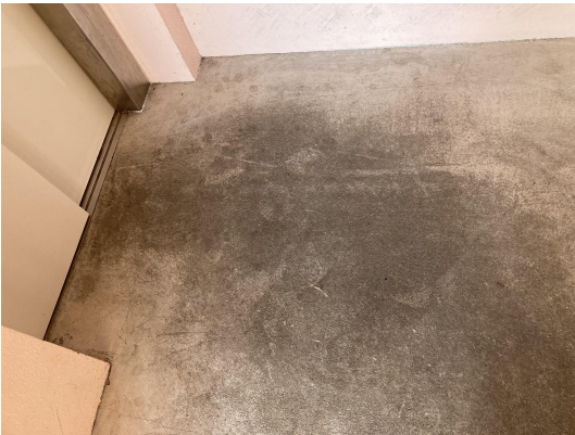
EV・ホール
