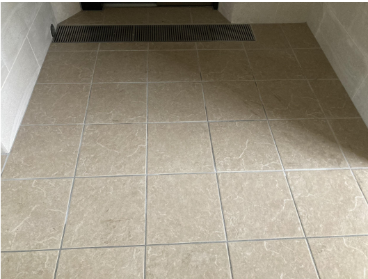
EV・ホール
