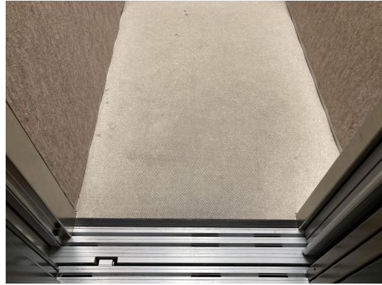
EV・ホール
